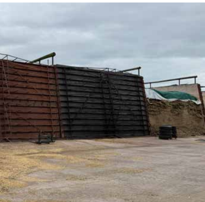
Die Silos werden mit einer Stahlklappe verschlossen. Bis zu 60m 3 werden täglich für die Fütterung der Kühe entnommen.
